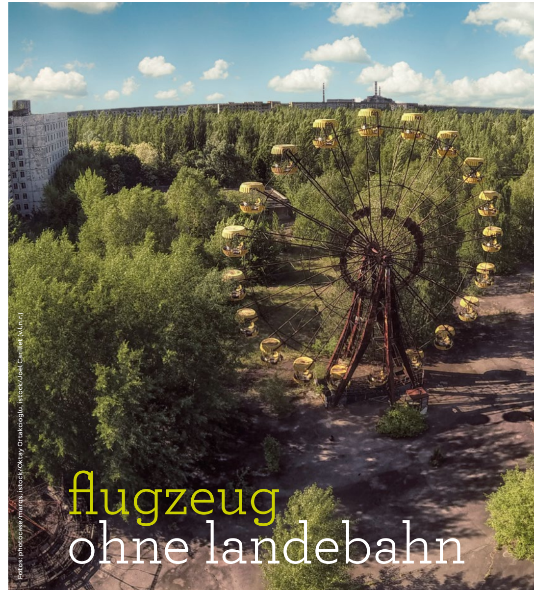
Die Stadt Pripyat inmitten der unbewohnbaren 30-Kilometer-Zone um das Kraftwerk Tschernobyl.
